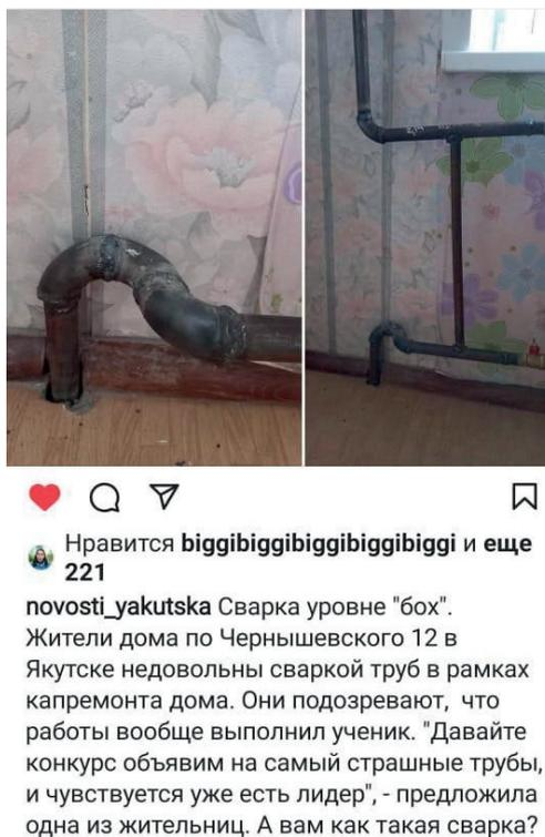
Рис. 1. Некачественный капремонт системы отопления зафиксирован и выложен в Интернет собственником квартиры по ул. Чернышевского, 12/1
